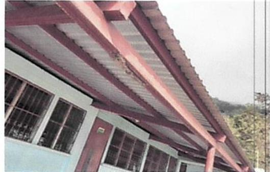
Foto 2: Instalación de canales y bajadas de agua.
